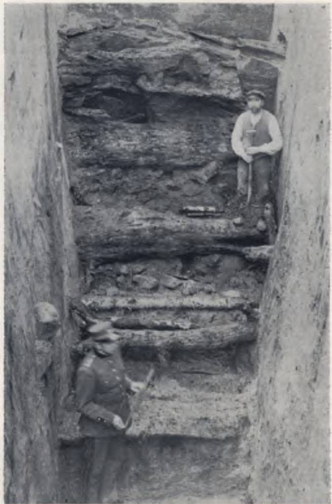
Perkastas pylimas parodė medinę konstrukciją.
