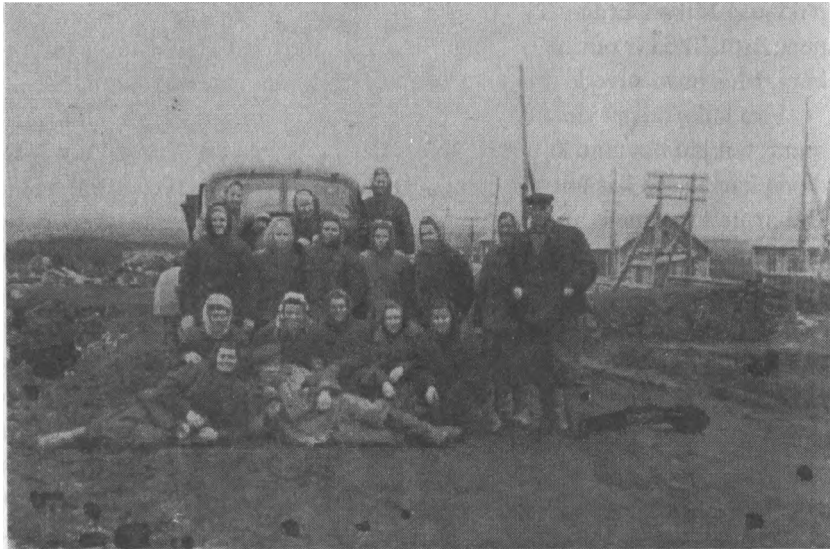
□ "Komjaunuoliai" komunizmo statyboje. 32-os šachtos kelio tiesimas. 1958 m. Vorkuta
